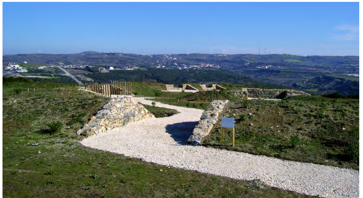
Vista geral do Reduto da Ajuda Grande, uma das obras militares integrada na Rota Histórica das Linhas de Torres, Loures.
