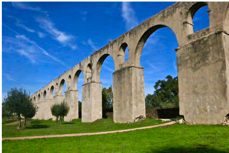
Aqueduto de Santo Antão do Tojal
